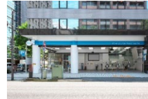
出光興産と提携して横浜にEV充電ステーションを建設 (日本・横浜市)
