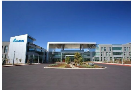
ビル自動化ソリューション
